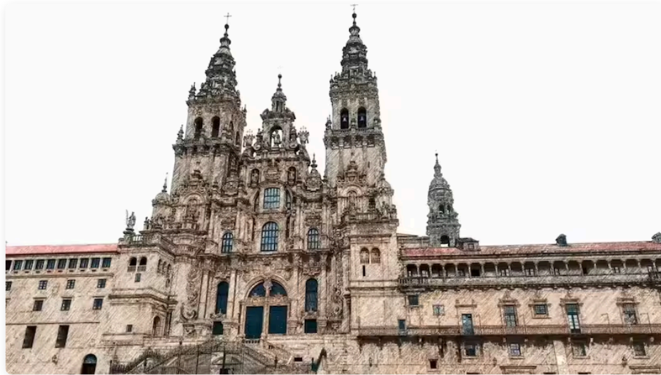
Fachada del Obradoiro de la Catedral
